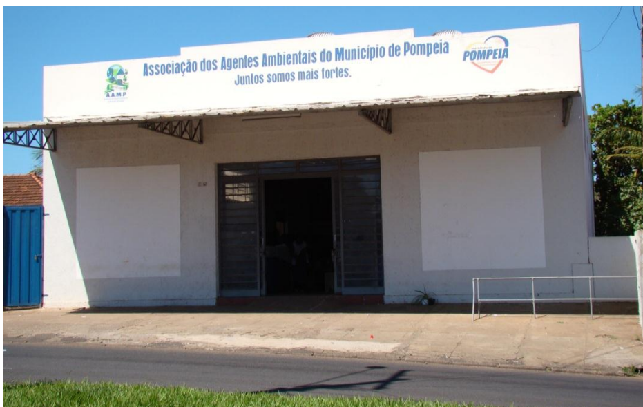
Imagem 26 – centro de triagem instalado na Vila Paulópolis, um distrito de Pompeia; o prédio é locado pela Prefeitura Municipal de Pompeia e cedido para a AAMP realizar os trabalhos de triagem e estocagem de recicláveis.
