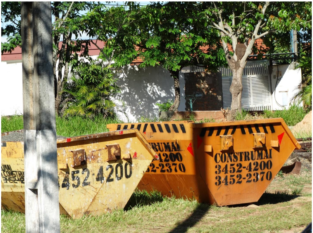
Imagem 47: caçambas coletoras de RCC dispostas em obras.
