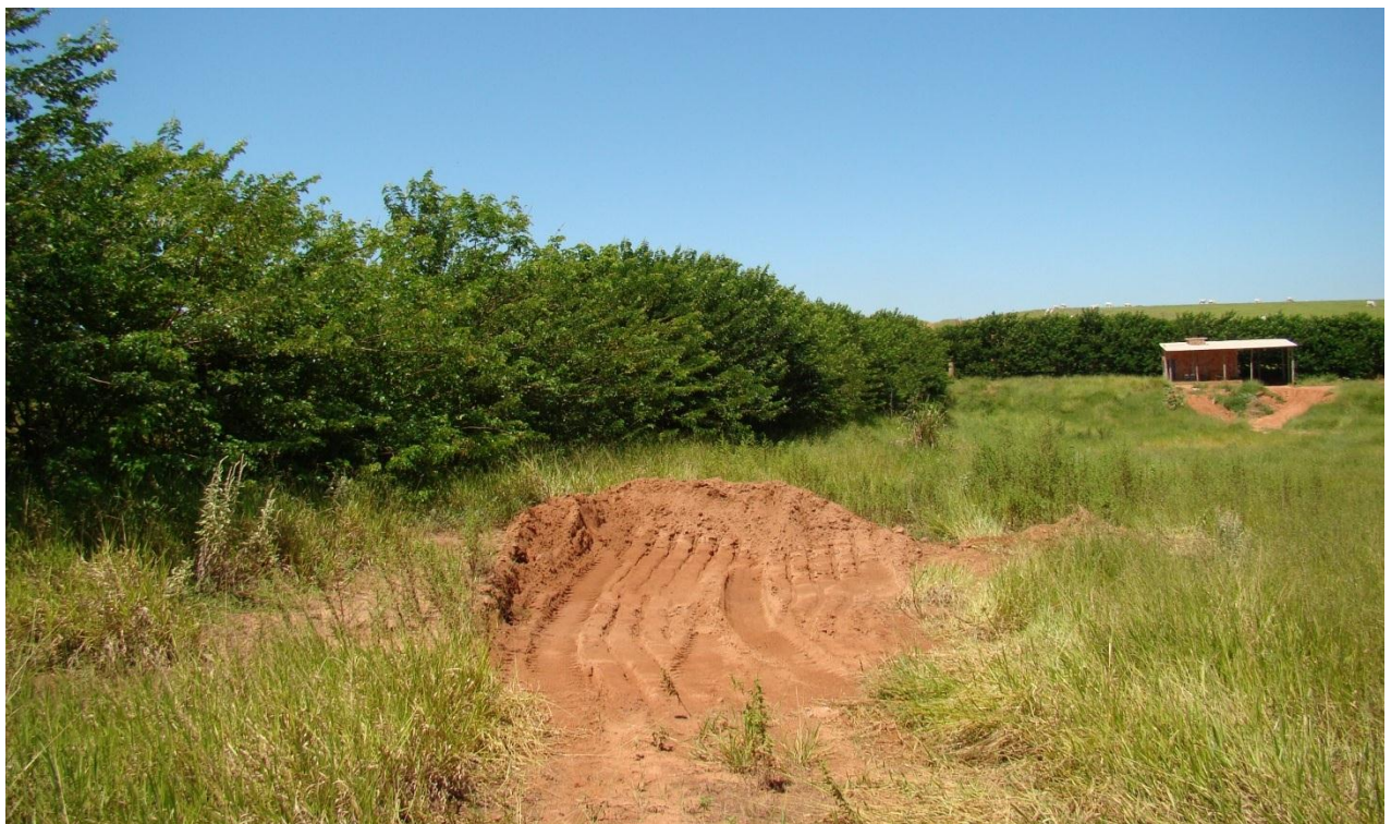
Imagem 18: vista interna do aterro em valas, com destaque para barreira vegetal composta por sansão do campo.
