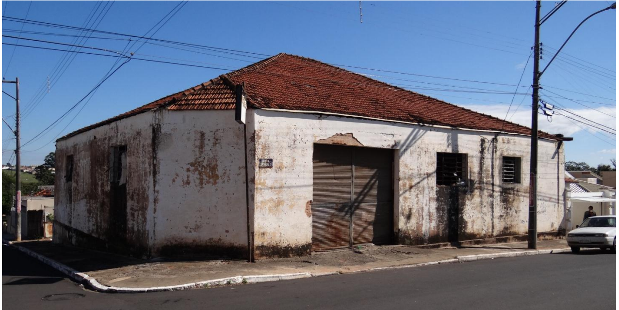
Imagem 48 – galpão utilizado como ponto de armazenamento temporário de pneumáticos inservíveis.
