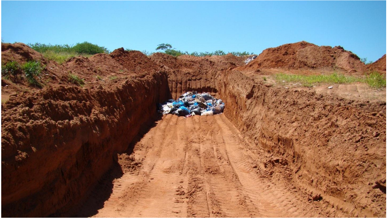
Imagem 19: vista interna do aterro em valas, com destaque para abertura de valas e destinação final dos resíduos.
