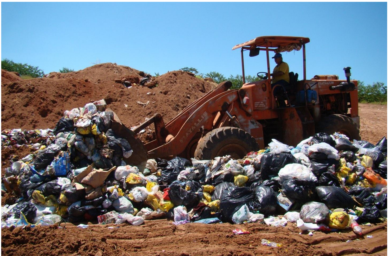
Imagem 20: cobertura diária de resíduos realizada com pá-carregadeira.
